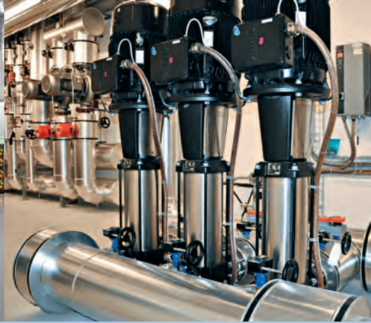
Pumpenanlage Fernwärme
